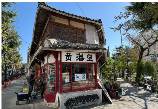
鎮海中心部に残る日本式建築物
